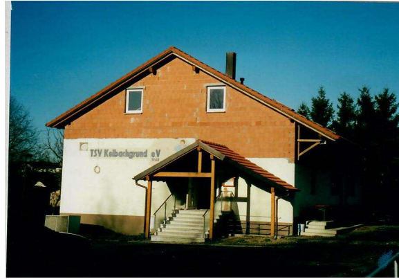
Umbau, Anbau, Erweiterung, Renovierung
